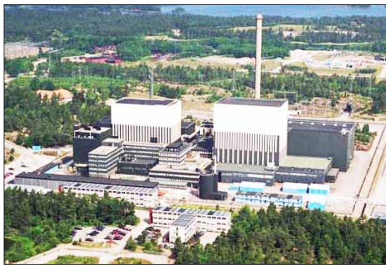
Forsmarks kärnkraftsanläggning har en viktig roll i svensk energiproduktion. Foto: Arkiv
